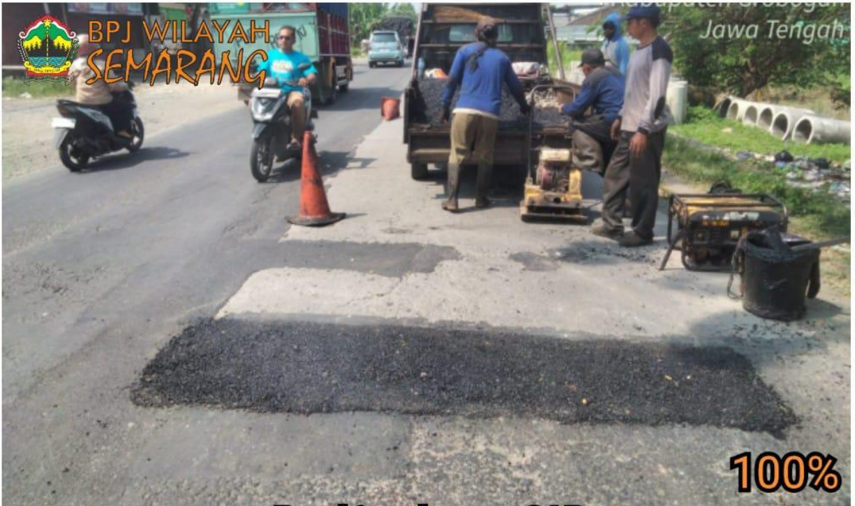
Patching dengan CAP Ruas Semarang-Godong KM. 28+790 (ka)
