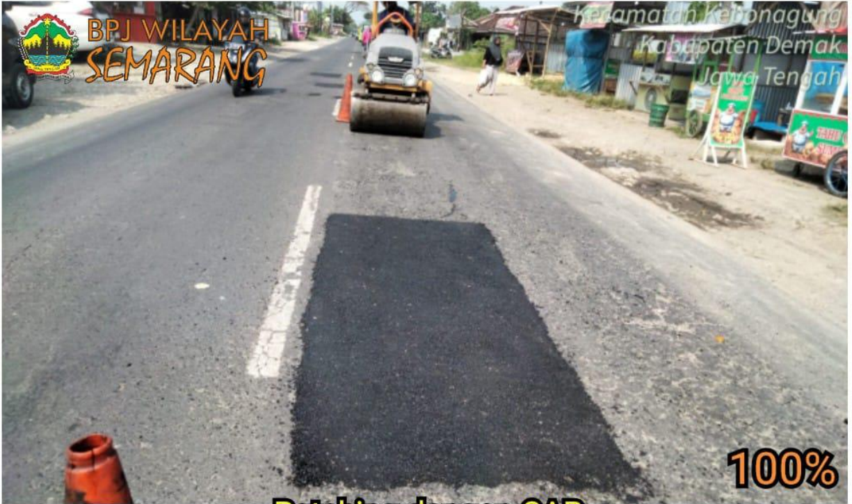
Patching dengan CAP Ruas Semarang-Godong KM. 39+450 (ka)
