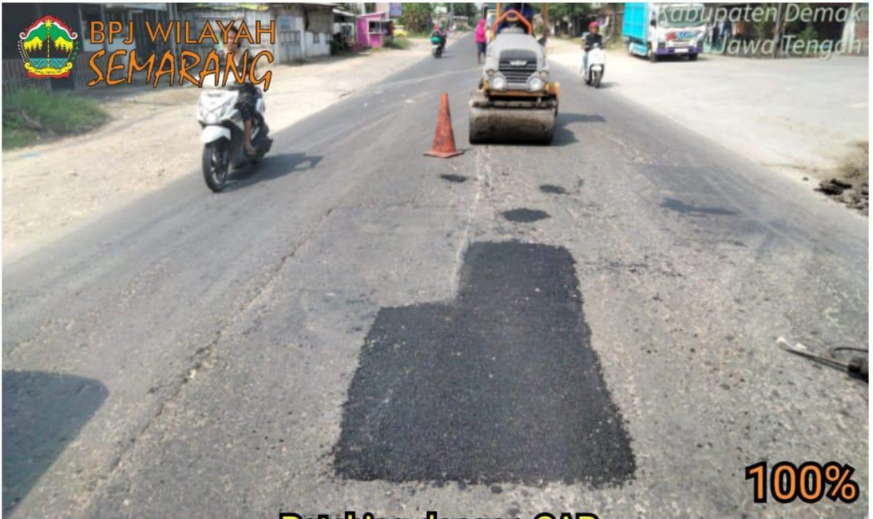
Patching dengan CAP Ruas Semarang-Godong KM. 39+500 (med)
