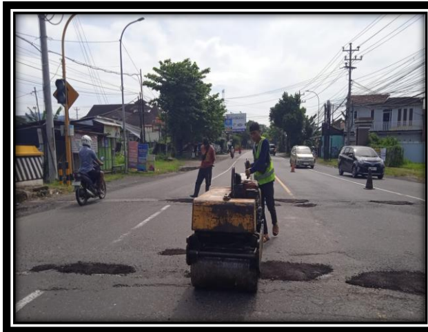
PEKERJAAN PERBAIKAN DENGAN CAMPURAN ASPAL PANAS (CAP) RUAS JALAN SP.3 TIMUR JLN. LINGKAR KUDUS – BTS. KAB. KUDUS/PATI (KM. SMG. 60+700 KIRI)
