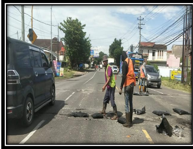
PEKERJAAN PERBAIKAN DENGAN CAMPURAN ASPAL PANAS (CAP) RUAS JALAN SP.3 TIMUR JLN. LINGKAR KUDUS – BTS. KAB. KUDUS/PATI (KM. SMG. 60+700 KIRI)
