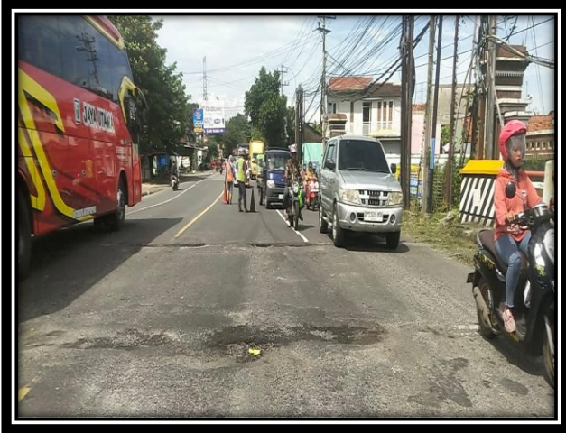
PEKERJAAN PERBAIKAN DENGAN CAMPURAN ASPAL PANAS (CAP) RUAS JALAN SP.3 TIMUR JLN. LINGKAR KUDUS – BTS. KAB. KUDUS/PATI (KM. SMG. 60+700 KIRI)
