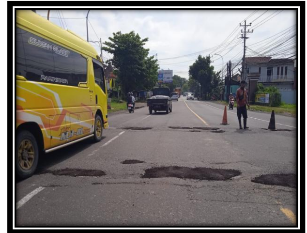
PEKERJAAN PERBAIKAN DENGAN CAMPURAN ASPAL PANAS (CAP) RUAS JALAN SP.3 TIMUR JLN. LINGKAR KUDUS – BTS. KAB. KUDUS/PATI (KM. SMG. 60+700 KIRI)
