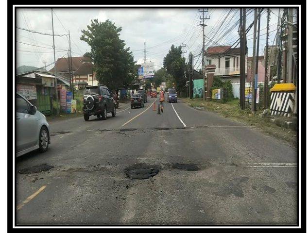
PEKERJAAN PERBAIKAN DENGAN CAMPURAN ASPAL PANAS (CAP) RUAS JALAN SP.3 TIMUR JLN. LINGKAR KUDUS – BTS. KAB. KUDUS/PATI (KM. SMG. 60+700 KIRI)
