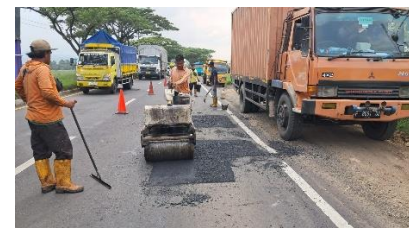
JALAN LINGKAR WELERI KM 45+700 (50%)
