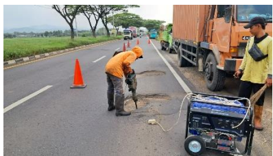
JALAN LINGKAR WELERI KM 45+700 (0%)
