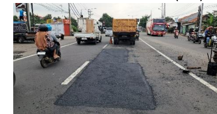
JALAN LINGKAR WELERI KM 47+800 (100%)
