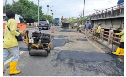
JEMBATAN BLUKAR A 50%
