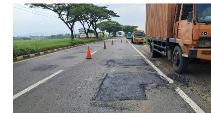
JALAN LINGKAR WELERI KM 45+700 (100%)
