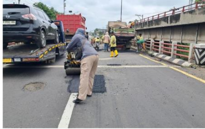
JEMBATAN BLUKAR A 50%
