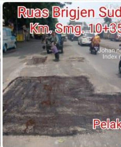
Pekerjaan Patching CAP
