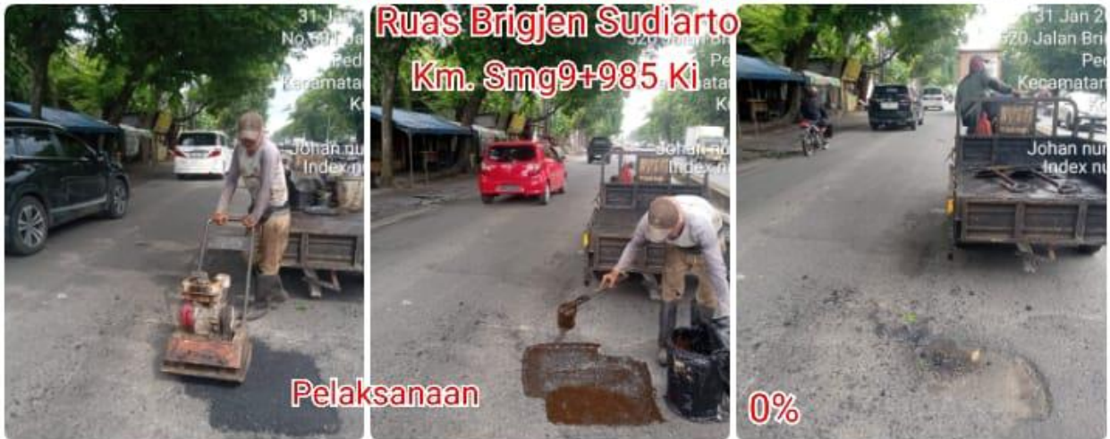
Pekerjaan Patching CAP
