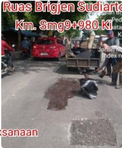
Pekerjaan Patching CAP
