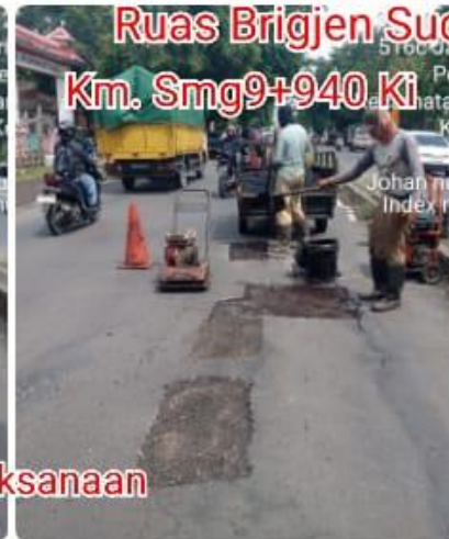
Pekerjaan Patching CAP
