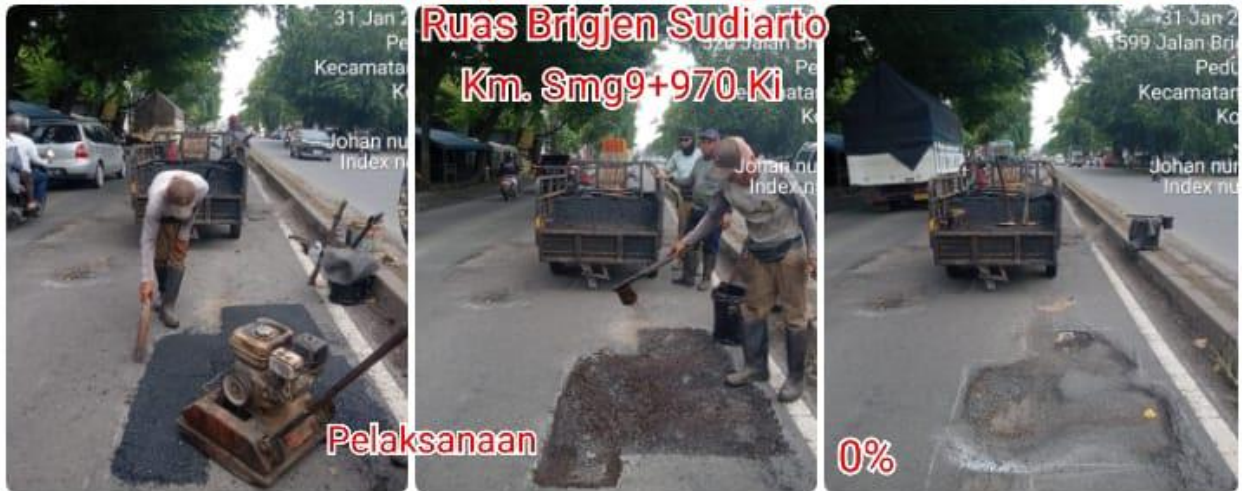
Pekerjaan Patching CAP
