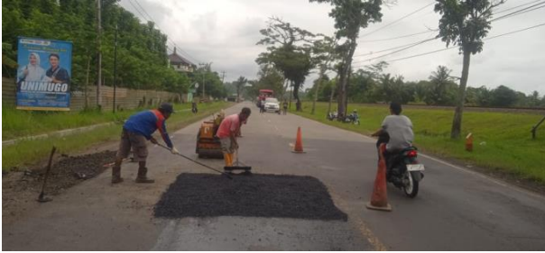
Ruas jalan Sp3 timur jalan lingkur sumpiuh - Bts.Kebumen
