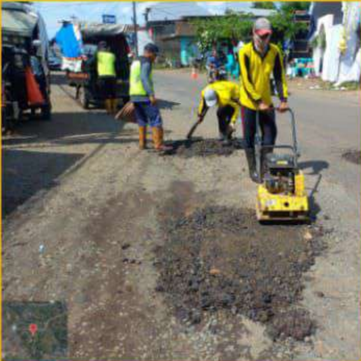
PEK TAMBAL LUBANG ASPAL KOLAKAN RUAS JL JEPARA-KELING KM.SMG 87+550 kiri TGL 26/02/2024
