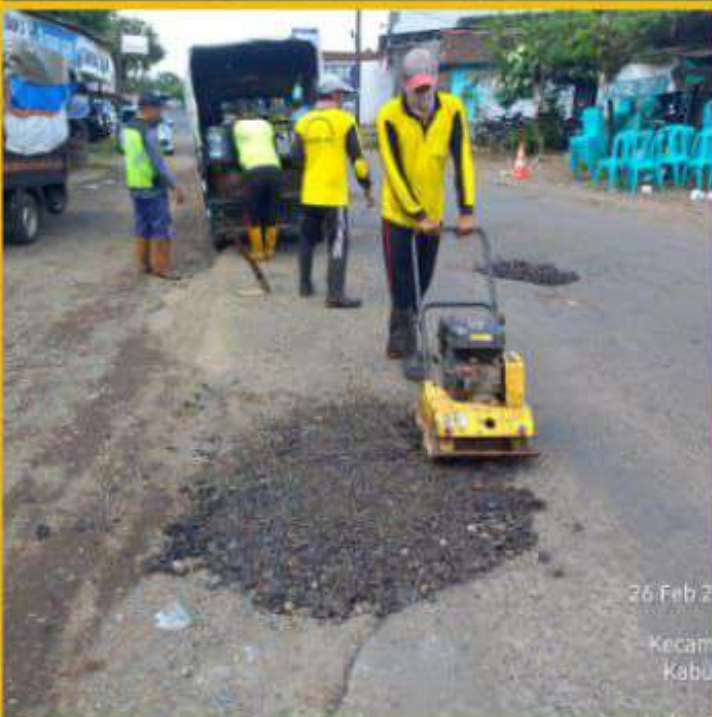
PEK TAMBAL LUBANG ASPAL KOLAKAN RUAS JL JEPARA-KELING KM.SMG 87+570 kiri TGL 26/02/2024
