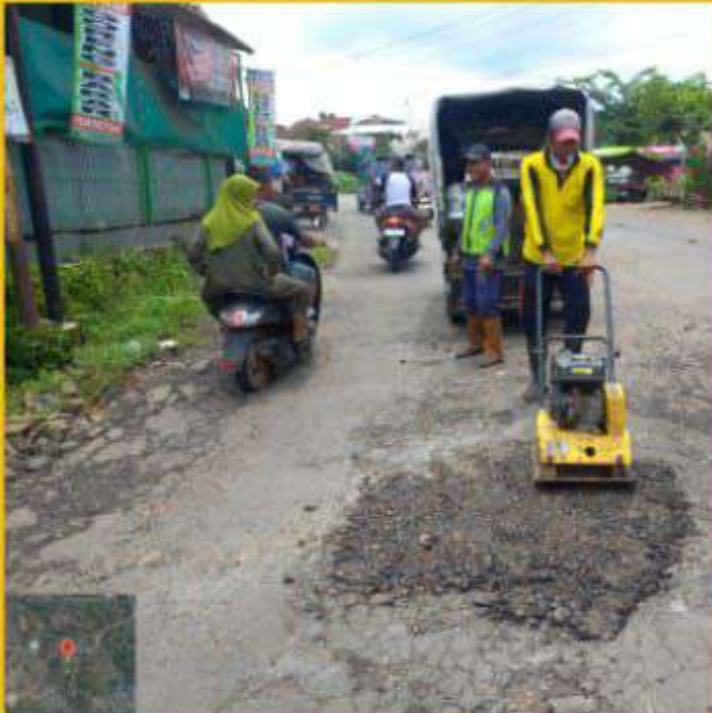
PEK TAMBAL LUBANG ASPAL KOLAKAN RUAS JL JEPARA-KELING KM.SMG 87+500 tengah TGL 26/02/2024
