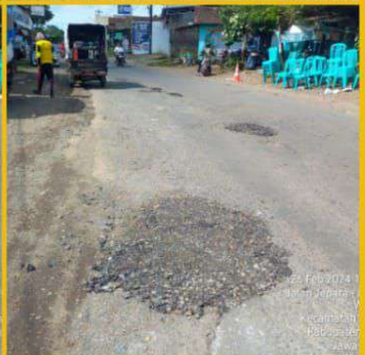
PEK TAMBAL LUBANG ASPAL KOLAKAN RUAS JL JEPARA-KELING KM.SMG 87+570 kiri TGL 26/02/2024
