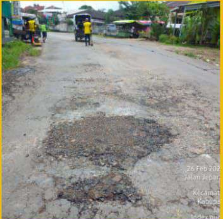
PEK TAMBAL LUBANG ASPAL KOLAKAN RUAS JL JEPARA-KELING KM.SMG 87+500 tengah TGL 26/02/2024
