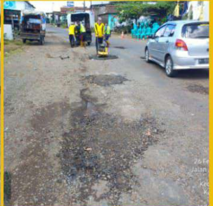
PEK TAMBAL LUBANG ASPAL KOLAKAN RUAS JL JEPARA-KELING KM.SMG 87+550 kiri TGL 26/02/2024
