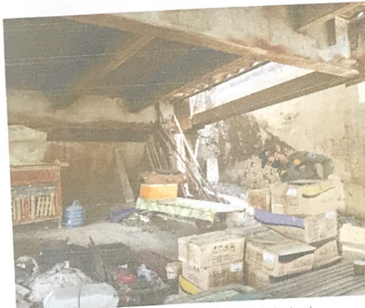
Gambar 2 2 (Kondisi di Bawah Jembatan)
