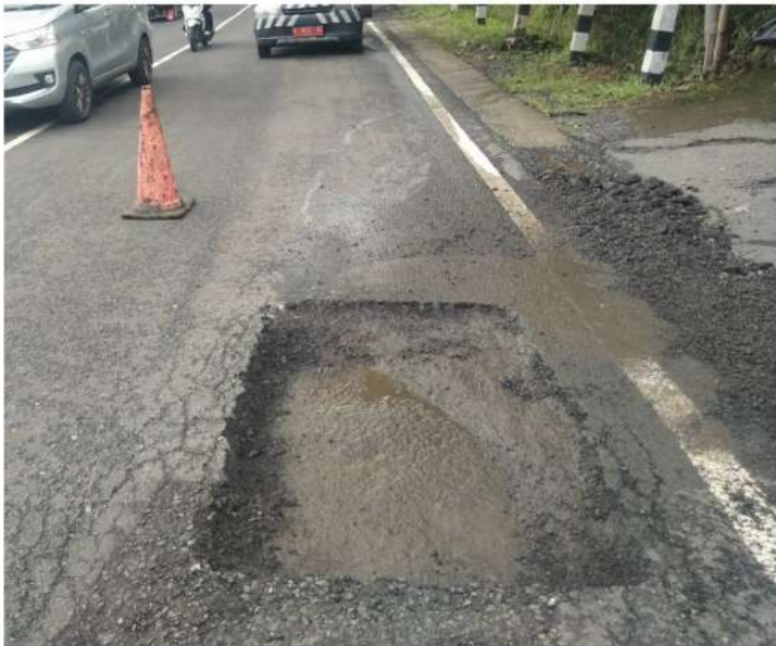
PEKERJAAN TAMBAL LUBANG RUAS JALAN KERTEK-SAPURAN KM 57+400
