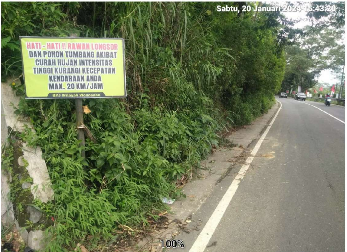
PEMASANGAN RAMBU-RAMBU PERINGATAN RUAS JALAN KERTEK-SAPURAN KM 65+700
