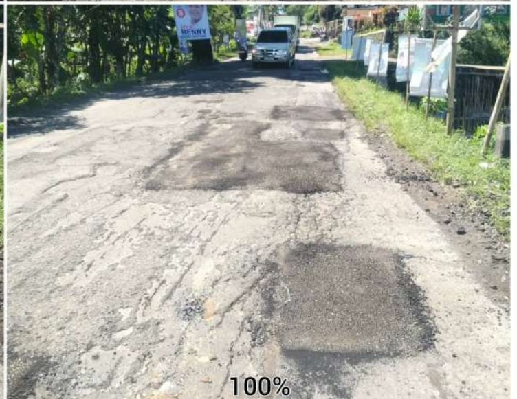
PEKERJAAN TAMBAL LUBANG RUAS JALAN KERTEK-SAPURAN KM 56+050
