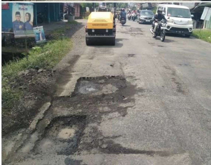
PEKERJAAN TAMBAL LUBANG RUAS JALAN KERTEK-SAPURAN KM 55+850
