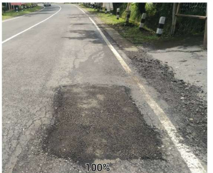
PEKERJAAN TAMBAL LUBANG RUAS JALAN KERTEK-SAPURAN KM 57+400
