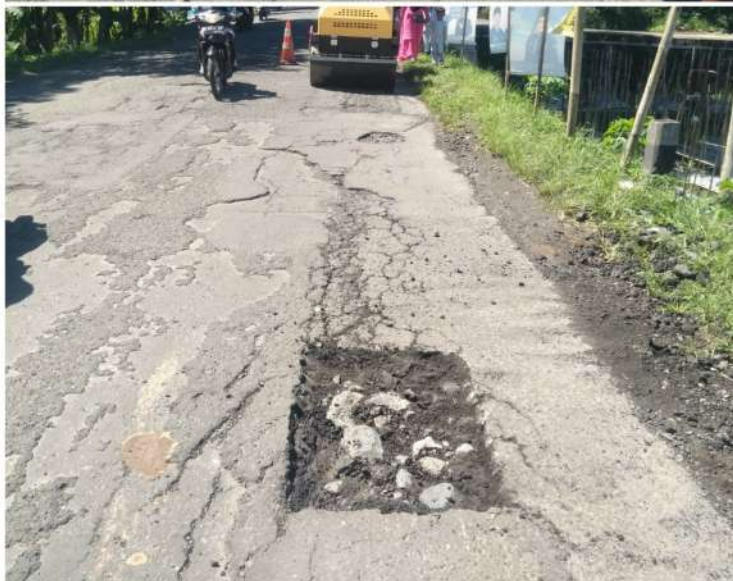
PEKERJAAN TAMBAL LUBANG RUAS JALAN KERTEK-SAPURAN KM 56+050
