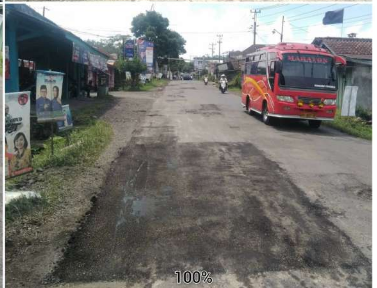
PEKERJAAN TAMBAL LUBANG RUAS JALAN KERTEK-SAPURAN KM 55+850
