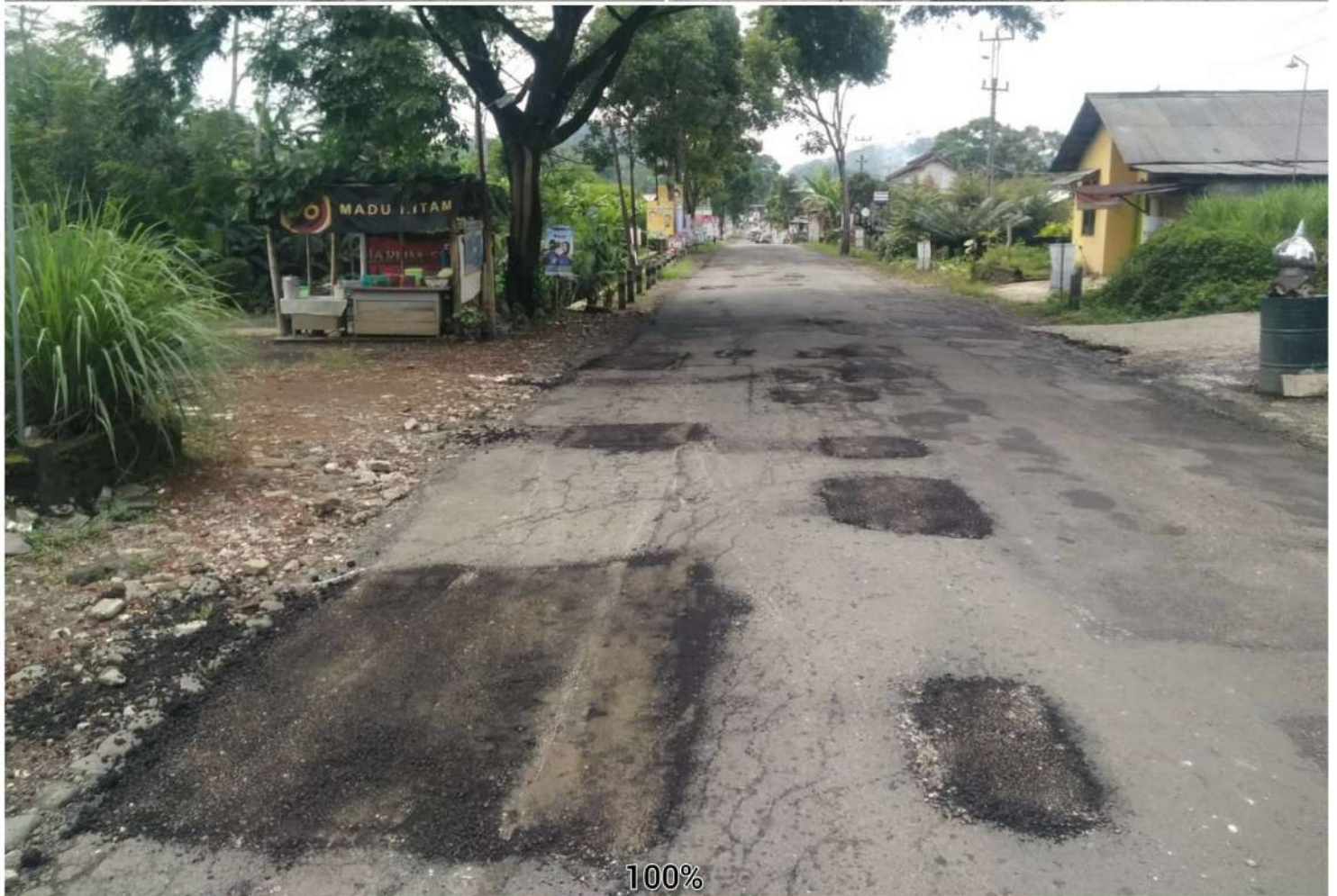
PEKERJAAN TAMBAL LUBANG RUAS JALAN KERTEK-SAPURAN KM 55+580
