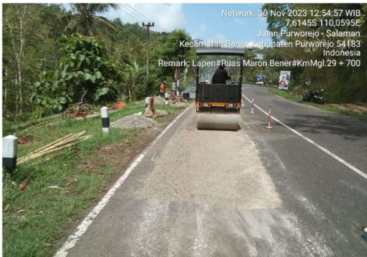
Pekerjaan Penambalan Jalan (Lapen) Bts. Kab. Purworejo/ Bener - Maron Ruas 169 Km.Mgl.29+700
