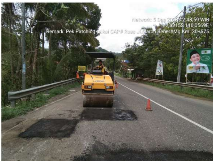
Pekerjaan Penambalan Lubang Bts. Kab. Purworejo/ Bener - Maron Ruas 169 Km.Mgl.30+575
