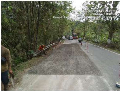
Pekerjaan Penambalan Jalan (Lapen) Bts. Kab. Purworejo/ Bener - Maron Ruas 169 Km.Mgl.30+900
