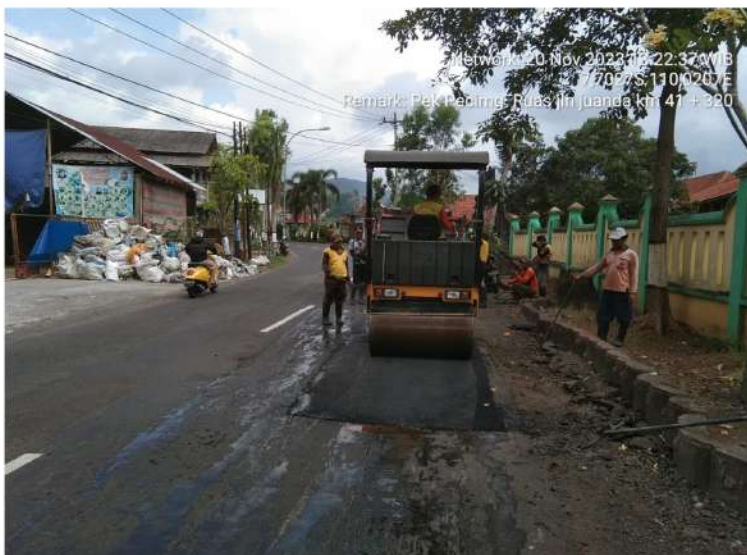
Pekerjaan Penambalan Lubang Jl. Ir. H. Juanda (Purworejo) Ruas 165.13.K Km.Mgl.41+320
