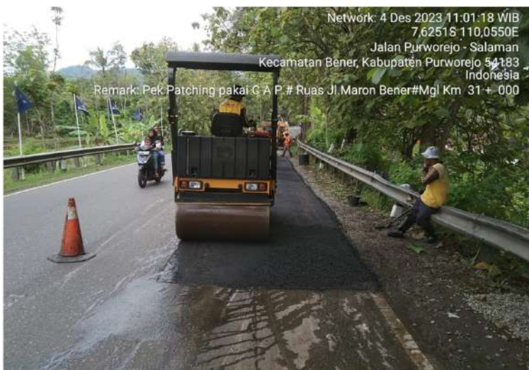
Pekerjaan Penambalan Jalan Bts. Kab. Purworejo/ Bener - Maron Ruas 169 Km.Mgl.31+000
