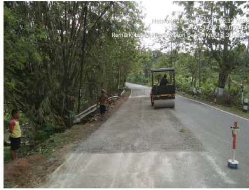
Pekerjaan Penambalan Jalan (Lapen) Bts. Kab. Purworejo/ Bener - Maron Ruas 169 Km.Mgl.30+900
