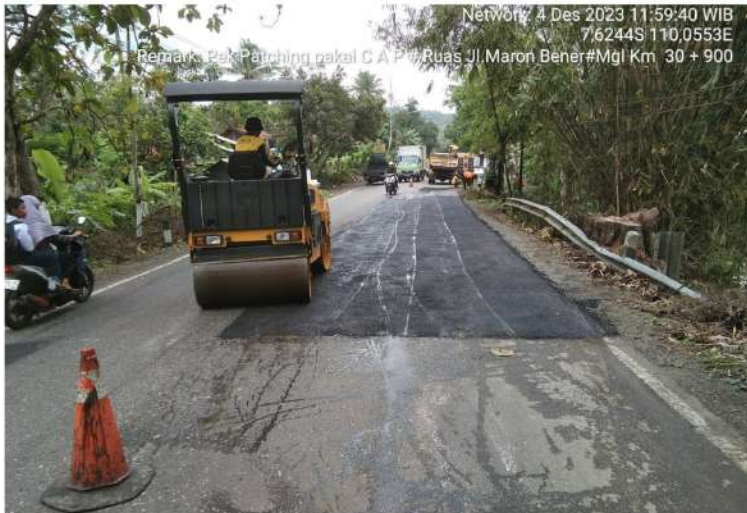
Pekerjaan Penambalan Jalan Bts. Kab. Purworejo/ Bener - Maron Ruas 169 Km.Mgl.30+900
