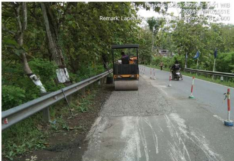
Pekerjaan Penambalan Jalan (Lapen) Bts. Kab. Purworejo/ Bener - Maron Ruas 169 Km.Mgl.31+000
