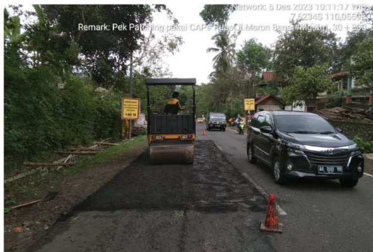
Pekerjaan Penambalan Lubang Bts. Kab. Purworejo/ Bener - Maron Ruas 169 Km.Mgl.30+700
