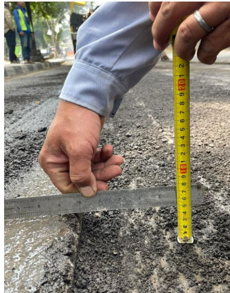
Foto: Pengecekan ketebalan CMM pada hari Rabu, 6 September 2023.
