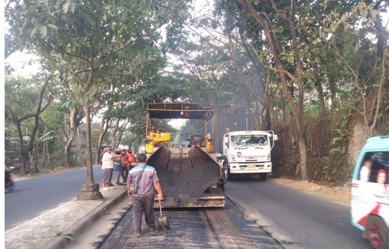
Foto: Pekerjaan CMM dan AC-BC penutup pada hari Rabu, 6 September 2023. Dan akan dilanjutkan untuk aspal lapis berikutnya. Dokumentasi tersebut di ruas terminal ke exit tol masuk kota Salatiga
