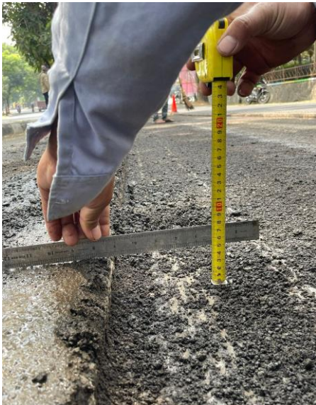
Foto: Pengecekan ketebalan CMM pada hari Rabu, 6 September 2023.
