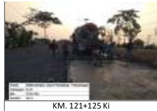
Pekerjaan Lapis Pondasi beton Korus
