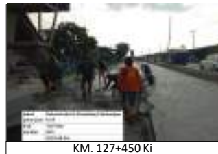
Pekerjaan Lapis Pondasi beton Korus
