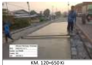
Pekerjaan Perkerasan Jalan Beton fs'45 umur 3 - 7 hari
