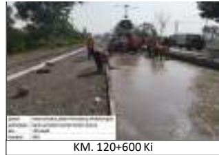
Pekerjaan Lapis Pondasi beton Korus
