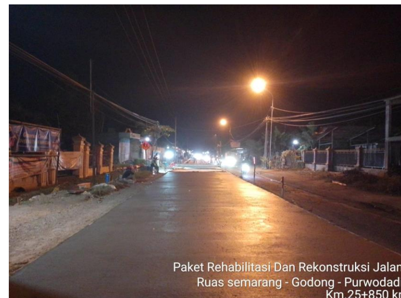
Paket Rehabilitasi Dan Rekonstruksi Jalan Ruas semarang - Godong - Purwodadi Km.25+850 kr
