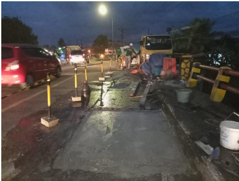
Penanganan plat lantai Jembatan Karanganyar pada hari Jumat 14 Juli 2023
