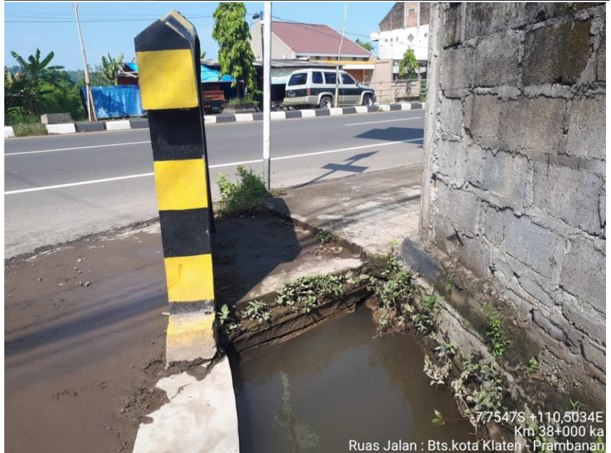
-7,7547S +110,5036E Km 38+000 ka Ruas Jalan : Bts.kota Klaten - Prambanan
