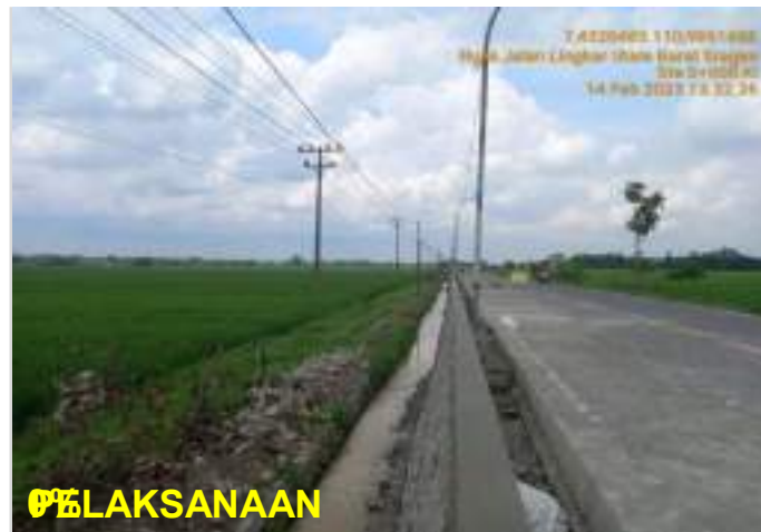
Pekerjaan Pasangan Batu Ruas Lingkaran Utara Barat (Sragen) Sta. 0+500 - 0+600 kiri
