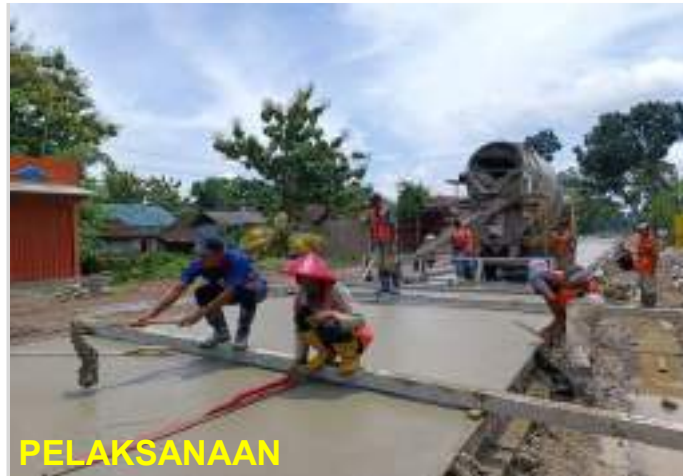
Pekerjaan Perkerasan Beton FS45 Ruas Surakarta - Gemolong (Sragen) - Purwodadi Km. 33+720 kanan
