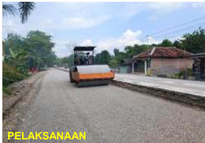
Pekerjaan Penghamparan dan Pemasatan Agregat Klas A Ruas Surakarta - Gemolong (Sragen) - Purwodadi Km. 33+850 sd 34+050 kiri
