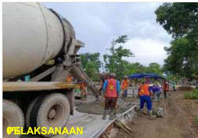
Pekerjaan Perkerasan Beton FS45 Ruas Surakarta - Gemolong (Sragen) - Purwodadi Km. 33+825 kanan
