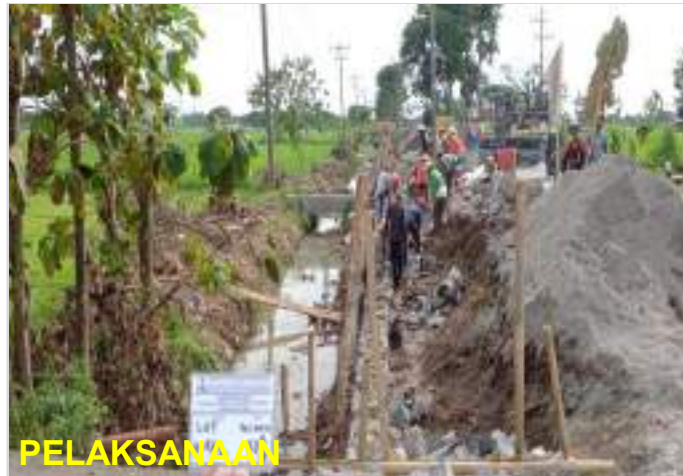
Pekerjaan Pasangan Batu Ruas Lingkak Utara Timur (Sragen) Sta. 0+430 kiri
