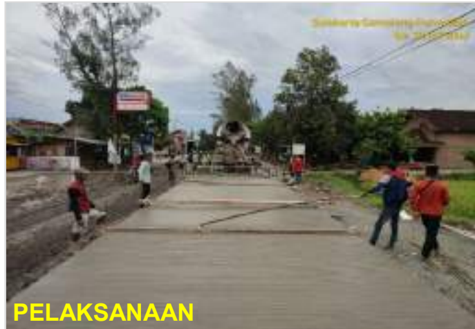
Pekerjaan Perkerasan Beton FS45 Ruas Surakarta - Gemolong (Sragen) - Purwodadi Km. 30+475 kanan
