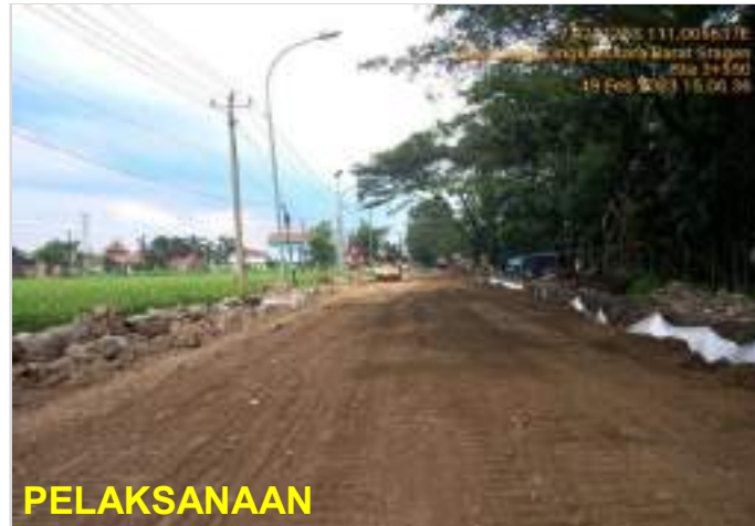
Pekerjaan Timbunan Pilihan Ruas Lingkaran Utara Barat (Sragen) Sta. 3+500 - 3+600
