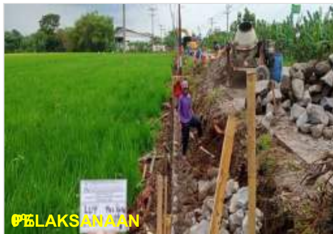
Pekerjaan Pasangan Batu Ruas Lingkak Utara Timur (Sragen) Sta. 1+115 kiri
