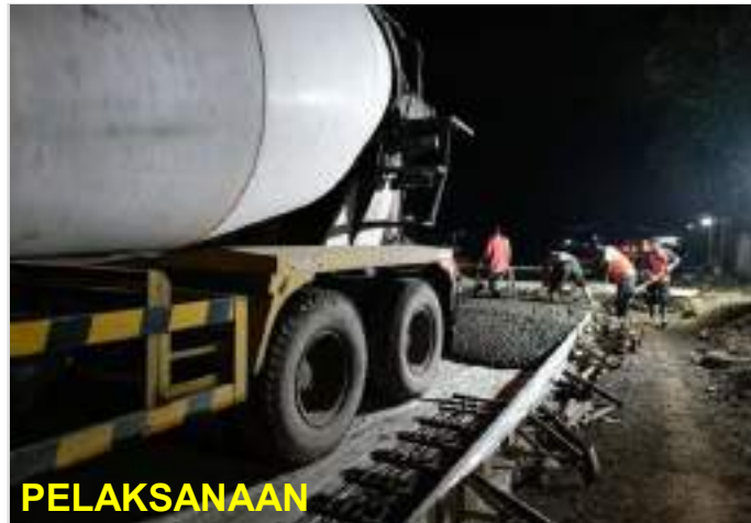
Pekerjaan Perkerasan Beton FS45 Ruas Surakarta - Gemolong (Sragen) - Purwodadi Km. 34+120 kanan
