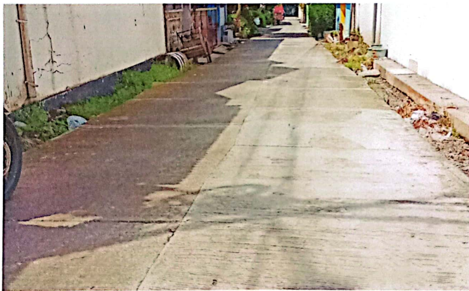
Pembangunan Jalan Rabat Beton Selatan Pasar Rakit TA. 2022
