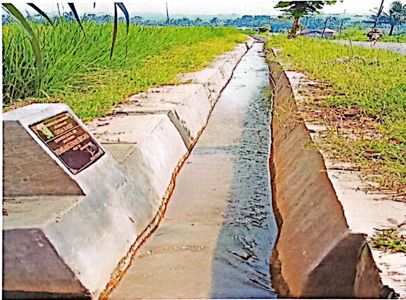
Pembangunan irigasi Blok 10 TA 2022 TA 2022
