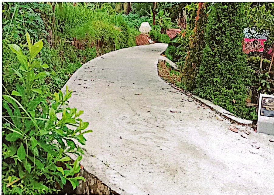
Pembangunan Jalan Rabat Beton RT 04 RW 04 TA. 2023
