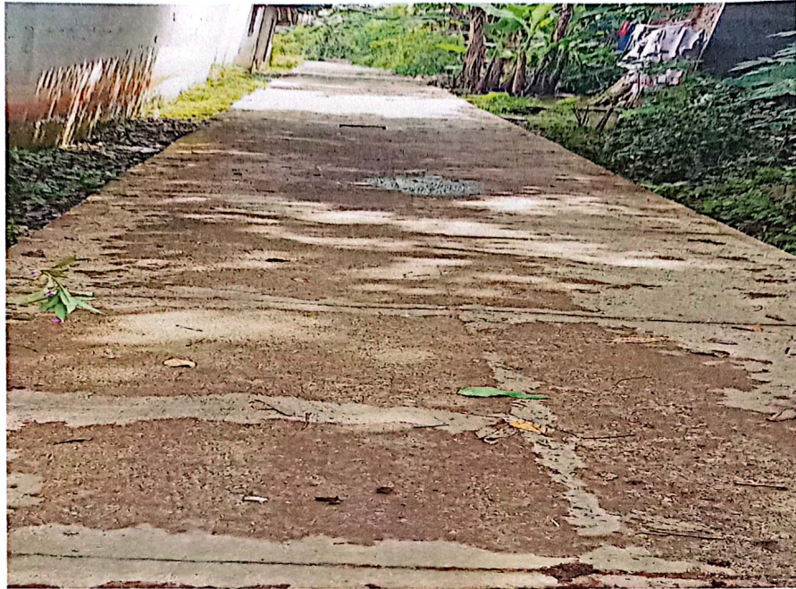
Pembangunan Jalan Rabat Beton RT 01 RW 04 TA 2022
