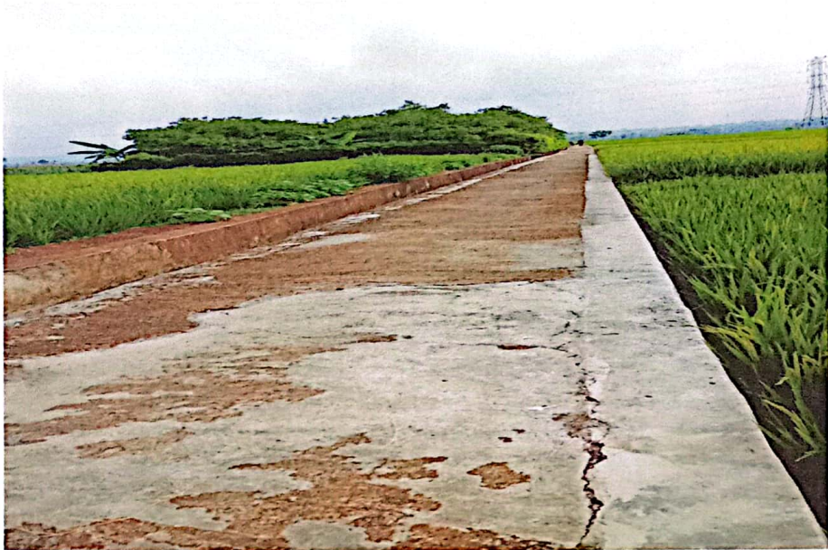
Pembangunan Jalan Usaha Tani Blok 18 TA.2022
