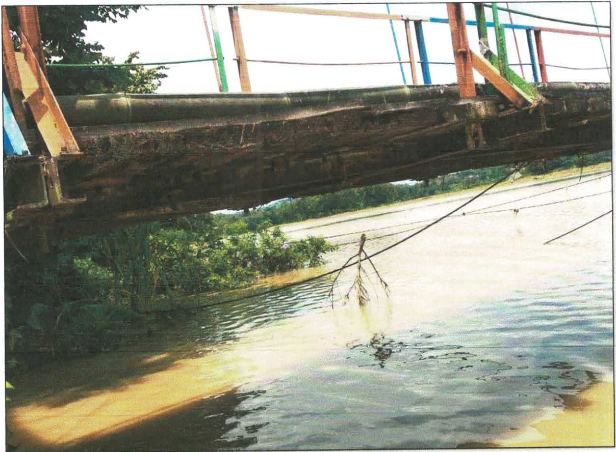
Jembatan Gantung Desa Bawu
