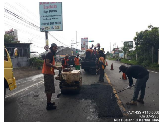
PENANGANAN LUBANG JLN. KARTINI (KLATEN) KM. 37+235 KA
