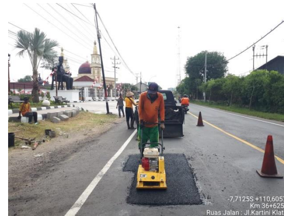
PENANGANAN LUBANG JLN. KARTINI (KLATEN) KM. 36+625 KA
