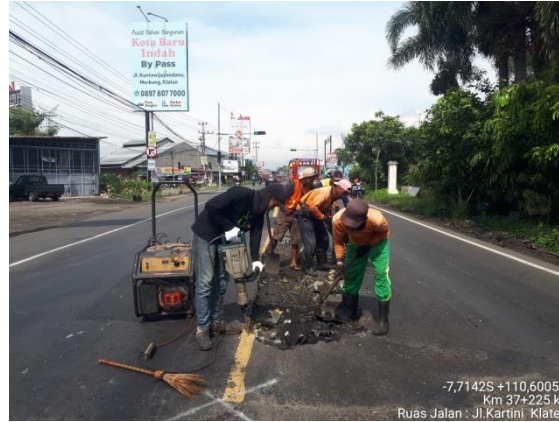
PENANGANAN LUBANG JLN. KARTINI (KLATEN) KM. 37+225 KA
