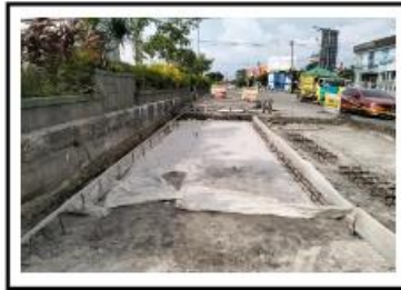
PEKERJAAN PENGEORAN FS 45 RUAS JALAN BTS. KAB. DEMAK/KUDUS – JATI (KUDUS) KM 46+200
