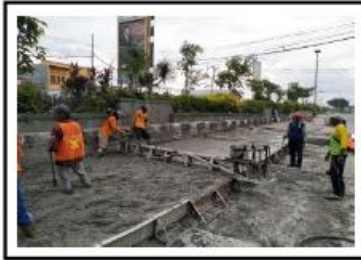
PEKERJAAN PENGEORAN FS 45 RUAS JALAN BTS. KAB. DEMAK/KUDUS – JATI (KUDUS) KM 46+200
