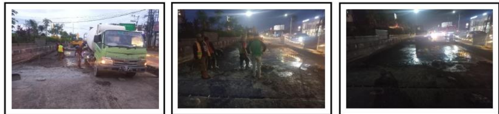
PEKERJAAN PENGECORAN BETON KURUS RUAS JALAN BTS. KAB. DEMAK/KUDUS – JATI (KUDUS) KM 46+200 KA
