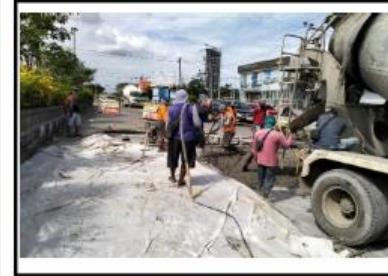
PEKERJAAN PENGEORAN FS 45 RUAS JALAN BTS. KAB. DEMAK/KUDUS – JATI (KUDUS) KM 46+200
