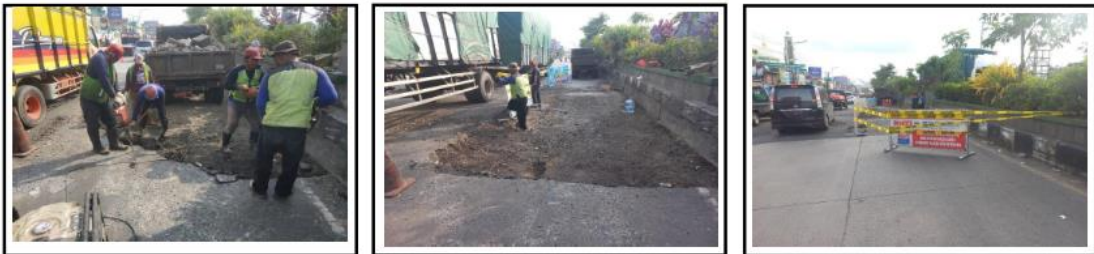
PEKERJAAN PEBAIKAN LOKASI BANJIR PENINGKATAN ASPAL MENJADI RIGID RUAS JALAN BTS. KAB. DEMAK/KUDUS – JATI (KUDUS) KM 46+200 KA
