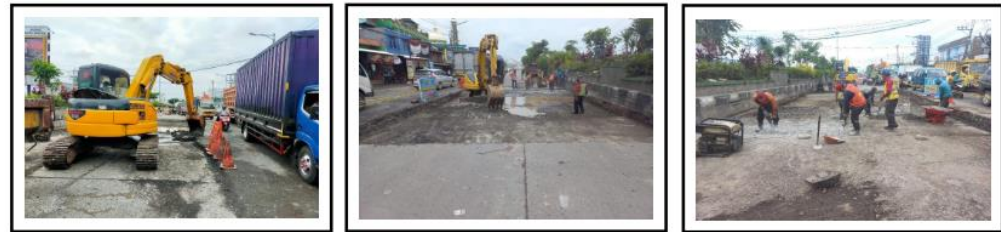
PEKERJAAN PERSIAPAN PENGECORAN BETON KURUS RUAS JALAN BTS. KAB. DEMAK/KUDUS – JATI (KUDUS) KM 46+200 KA
