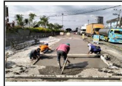
PEKERJAAN PENGEORAN FS 45 RUAS JALAN BTS. KAB. DEMAK/KUDUS – JATI (KUDUS) KM 46+200
