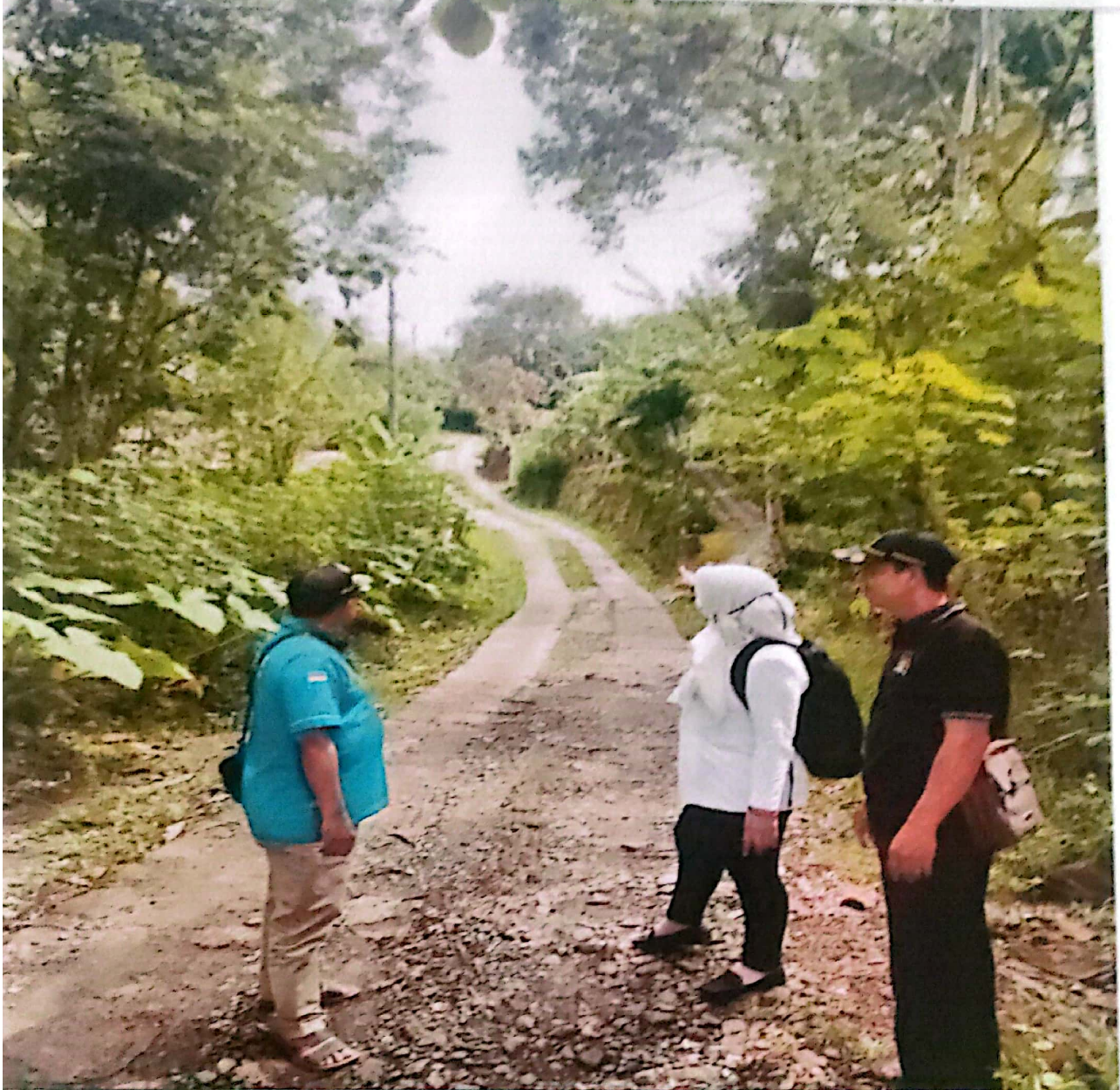
TIM KECAMATAN SRUWENG BERSAMA KEPALA DESA DAN KASI DESA PAKURAN MELAKUKAN SURVEY KE LOKASI JALAN YANG RUSAK DI DESA PAKURAN
