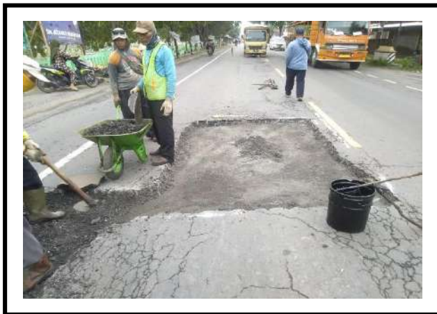
PEKERJAAN PENANGANAN LUBANG RUAS JALAN BTS. KOTA REMBANG – BULU (BTS. PROV. JATIM) KM 144+200
