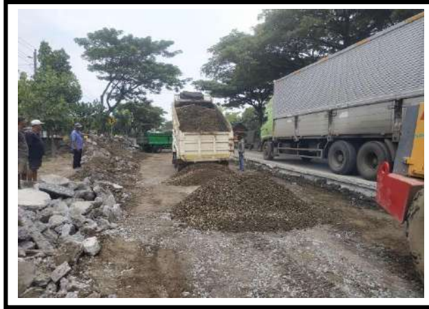
PEKERJAAN TIMBUNAN LAPIS DRAINASE RUAS JALAN SP.3 LINGKAR APATI TIMUR – BTS. KOTA REMBANG KM 93+035
