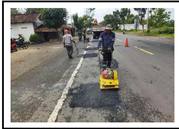
PEKERJAAN PENANGANAN LUBANG RUAS JALAN BTS. KOTA REMBANG – BULU (BTS. PROV. JATIM) KM 143+700
