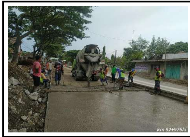
PEKERJAAN PENGECORAN BETON KURUS RUAS JALAN SP.3 LINGKAR APATI TIMUR – BTS. KOTA REMBANG KM 92+975
