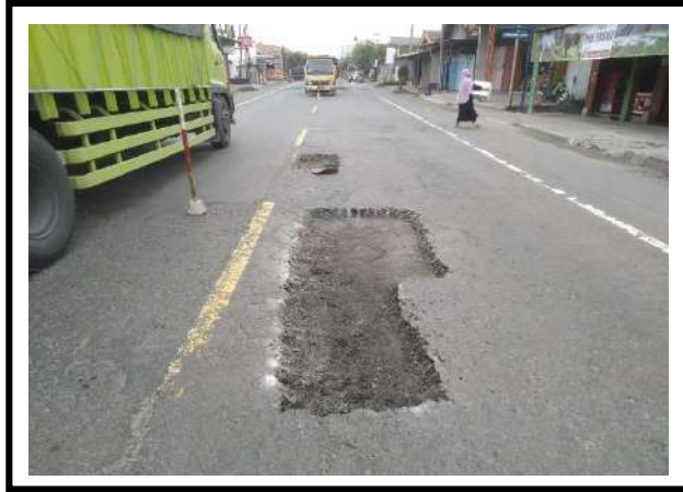
PEKERJAAN PENANGANAN LUBANG RUAS JALAN BTS. KOTA REMBANG – BULU (BTS. PROV. JATIM) KM 144+370
