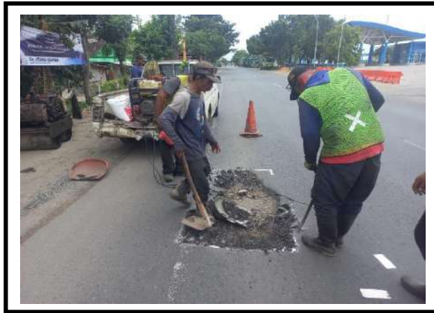
PEKERJAAN PENANGANAN LUBANG RUAS JALAN BTS. KOTA REMBANG – BULU (BTS. PROV. JATIM) KM 158+250
