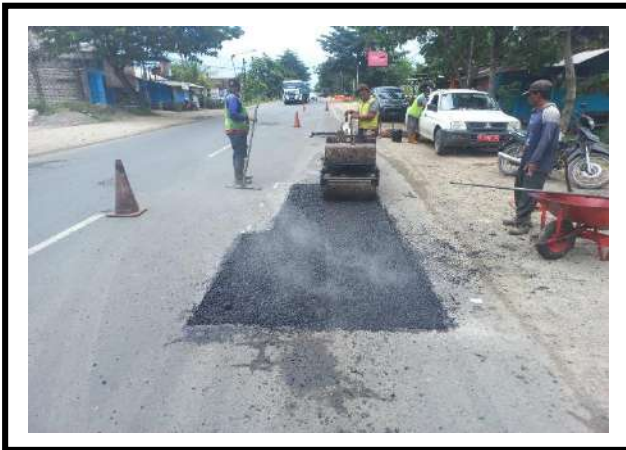
PEKERJAAN PENANGANAN LUBANG RUAS JALAN BTS. KOTA REMBANG – BULU (BTS. PROV. JATIM) KM 158+180
