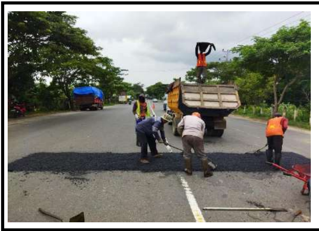
PEKERJAAN PENANGANAN LUBANG RUAS JALAN BTS. KOTA REMBANG – BULU (BTS. PROV. JATIM) KM 143+100
