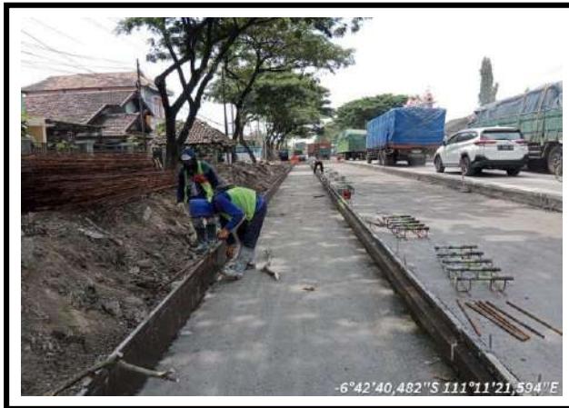
PEKERJAAN PEMASANGAN BEKISTING RUAS JALAN SP.3 LINGKAR APATI TIMUR – BTS. KOTA REMBANG KM 93+035
