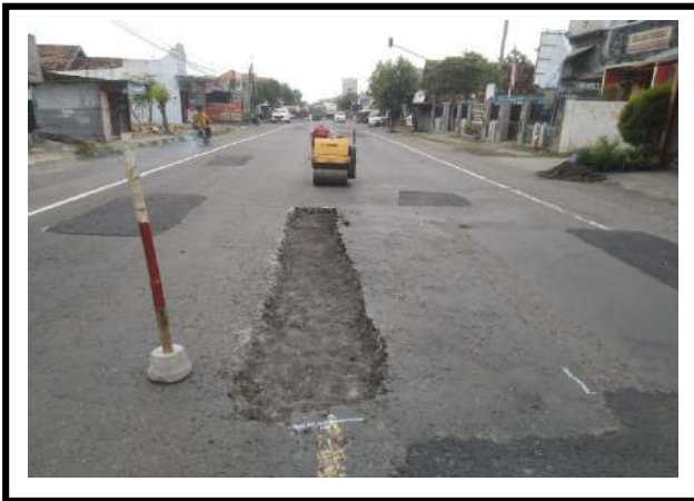
PEKERJAAN PENANGANAN LUBANG RUAS JALAN BTS. KOTA REMBANG – BULU (BTS. PROV. JATIM) KM 144+400
