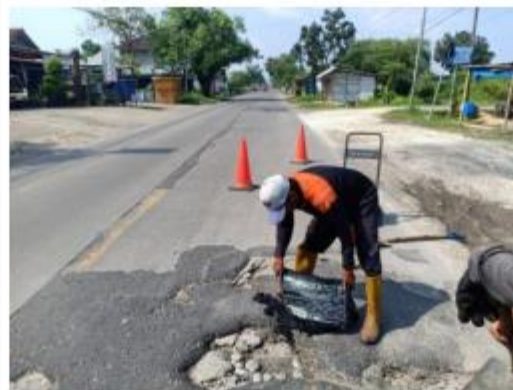
PEKERJAAN PENUTUPAN LUBANG MENGGUNAKAN COLDMIX TRENGGULI-BTS KAB DEMAK/BTS KAB JEPARA
