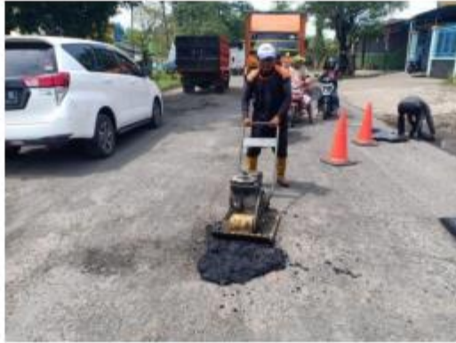
PEKERJAAN PENUTUPAN LUBANG MENGGUNAKAN COLDMIX TRENGGULI-BTS KAB DEMAK/BTS KAB JEPARA
