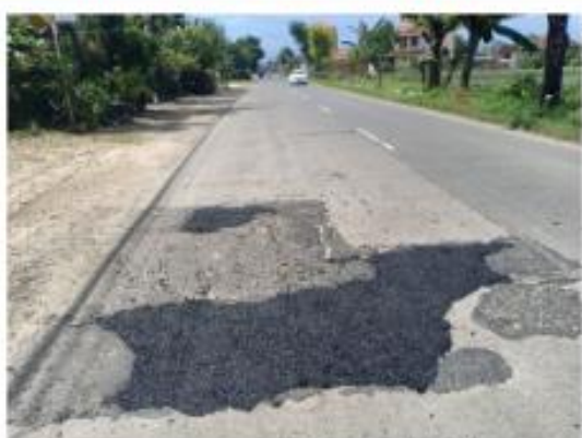
PEKERJAAN SAPU LOBANG DENGAN COLD MIX TRENGGULI – BTS DEMAK/ JEPARA
