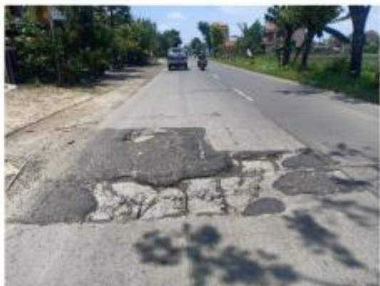
PEKERJAAN SAPU LOBANG DENGAN COLD MIX TRENGGULI – BTS DEMAK/ JEPARA
