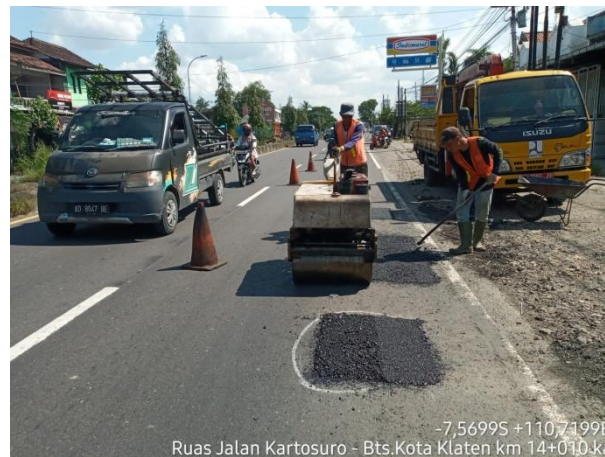
PENANGANAN LUBANG KARTOSURO-BTS KOTA KLATEN KM. 14+010 KA
