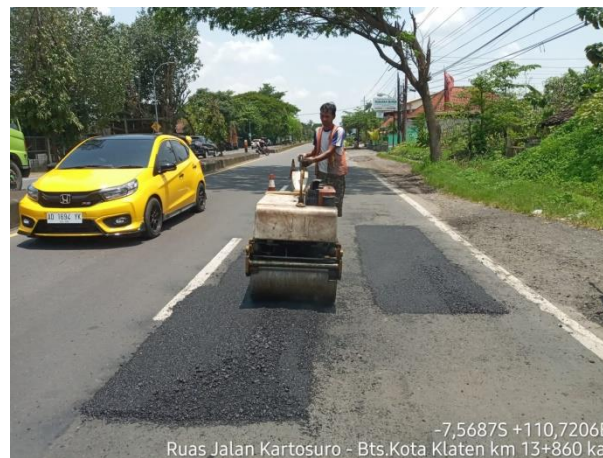
PENANGANAN LUBANG KARTOSURO-BTS KOTA KLATEN KM. 13+860 KA
