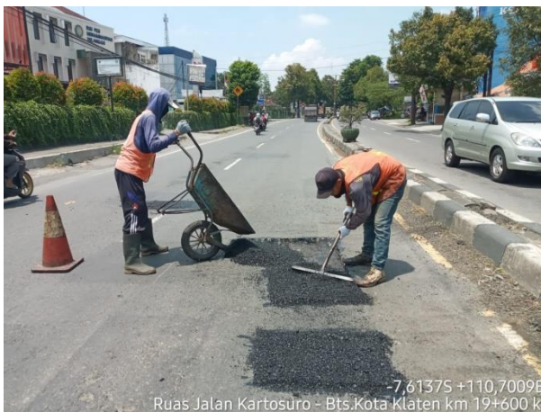
PENANGANAN LUBANG KARTOSURO-BTS KOTA KLATEN KM. 19+600 KI
