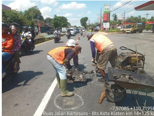
PENANGANAN LUBANG KARTOSURO-BTS KOTA KLATEN KM. 14+125 KA
