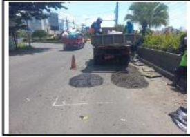
PEKERJAAN PENANGANAN LUBANG DENGAN COLD MIX RUAS BTS. KAB. DEMAK/KUDUS – JATI (KUDUS) KM 47+185 KA
