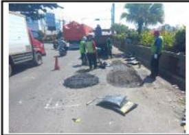
PEKERJAAN PENANGANAN LUBANG DENGAN COLD MIX RUAS BTS. KAB. DEMAK/KUDUS – JATI (KUDUS) KM 47+185 KA
