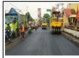
PEKERJAAN OPRIT JEMBATAN KLALING AC-WC MOD RUAS SP.3 LINGKAR KUDUS – BTS. KAB. PATI/KUDUS KM 60+100
