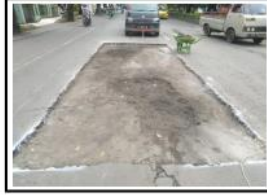
PEKERJAAN PENANGANAN LUBANG RUAS JALAN BTS. KAB. DEMAK/KUDUS – JATI (KUDUS) KM 49+150
