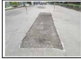
PEKERJAAN PENANGANAN LUBANG RUAS JALAN BTS. KAB. DEMAK/KUDUS – JATI (KUDUS) KM 49+100
