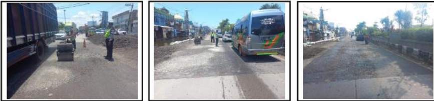
PEKERJAAN CTB DENGAN RAP GALIAN CMM RUAS BTS. KAB. DEMAK/KUDUS – JATI (KUDUS) KM 46+400 KA
