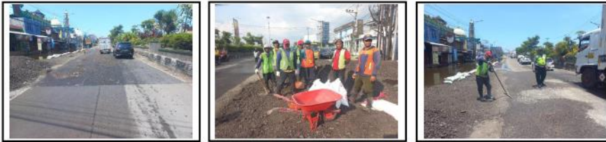
PEKERJAAN CTB DENGAN RAP GALIAN CMM RUAS BTS. KAB. DEMAK/KUDUS – JATI (KUDUS) KM 46+400 KA
