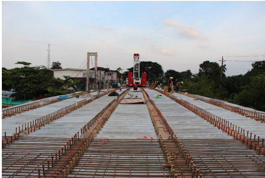
Pelaksanaan Pekerjaan di Jembatan Juwana Pati
