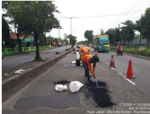
PENANGANAN LUBANG BTS KOTA KLATEN-PRAMBANAN KM. 41+355 KA
