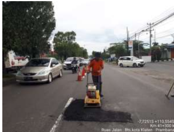
PENANGANAN LUBANG BTS KOTA KLATEN-PRAMBANAN KM. 41+300 KA
