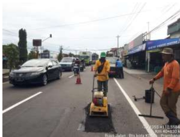
PENANGANAN LUBANG BTS KOTA KLATEN-PRAMBANAN KM. 40+830 KA
