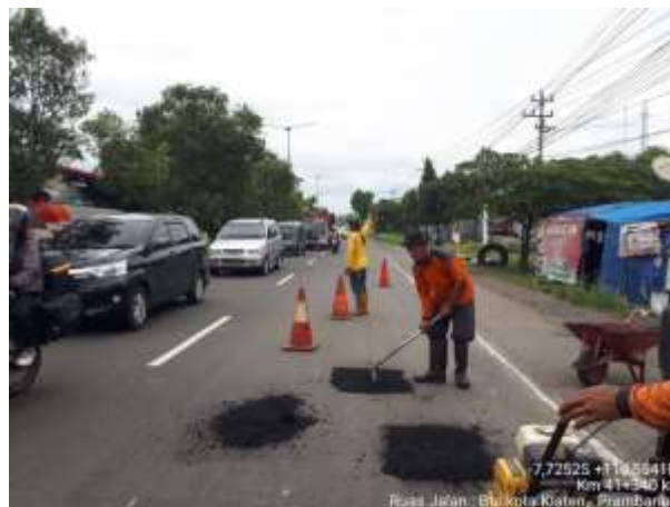
PENANGANAN LUBANG BTS KOTA KLATEN-PRAMBANAN KM. 41+340 KA
