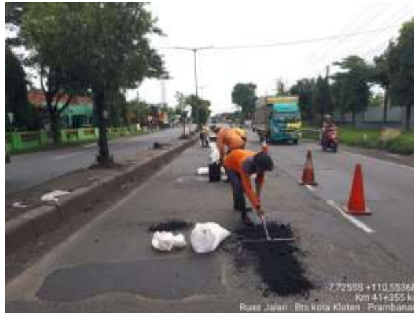
PENANGANAN LUBANG BTS KOTA KLATEN-PRAMBANAN KM. 41+355 KA
