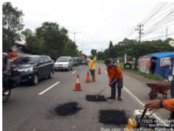
PENANGANAN LUBANG BTS KOTA KLATEN-PRAMBANAN KM. 41+340 KA
