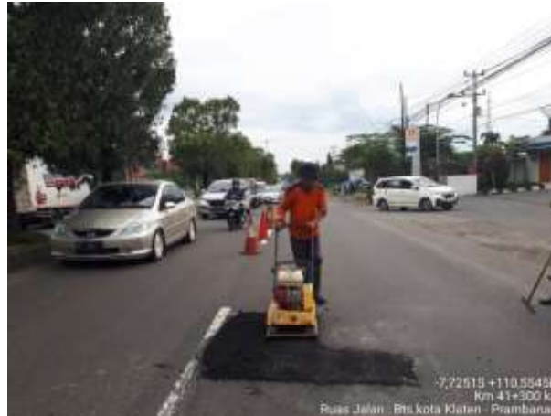
PENANGANAN LUBANG BTS KOTA KLATEN-PRAMBANAN KM. 41+300 KA
