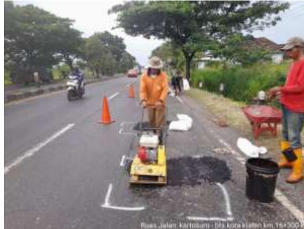
PENANGANAN LUBANG KARTOSURO-BTS KOTA KLATEN KM. 16+300 KA
