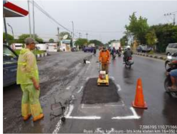
PENANGANAN LUBANG KARTOSURO-BTS KOTA KLATEN KM. 16+050 KI
