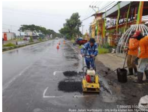
PENANGANAN LUBANG KARTOSURO-BTS KOTA KLATEN KM. 16+090 KA
